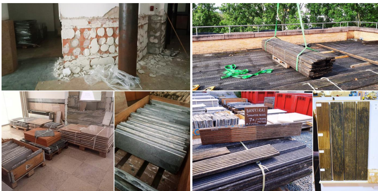
Twin Falls - Démantèlement des revêtements en pierre © Rotor asbl
